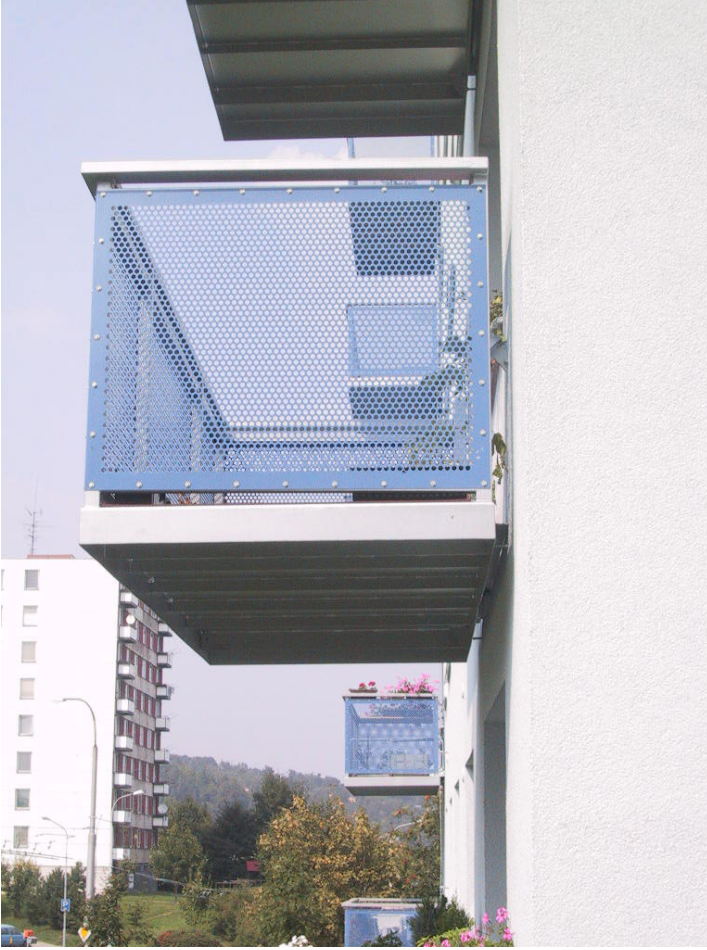
Şekil 26. Dış Duvar Balkon Uygulaması
