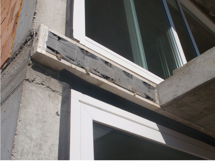
Şekil 28. Dış Duvar Konsol Balkon Uygulaması
