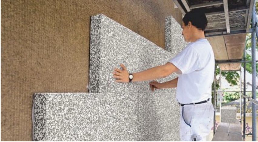
Şekil 44. Duvar Yalıtımı Uygulaması
